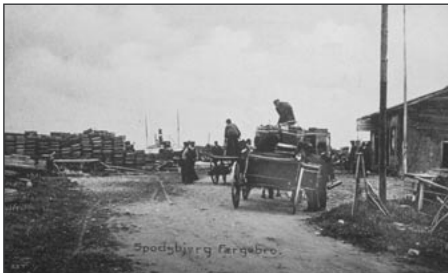
Færgestederne havde kgl. privilegerede færgemænd, men omkring 1860 blev de gamle færgébåde afløst af dampskibe. Her ses Spodsbjerg færgebro med et dampskib i baggrunden.
