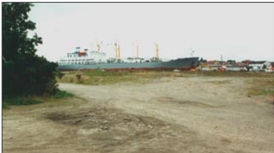
Den totalsanerede dampskibsmole i Nyborg havn. De to skibe i baggrunden ligger ved kajen på havnens vestside. Havnarealerne er ryddet for at give plads til boligbyggeri.
